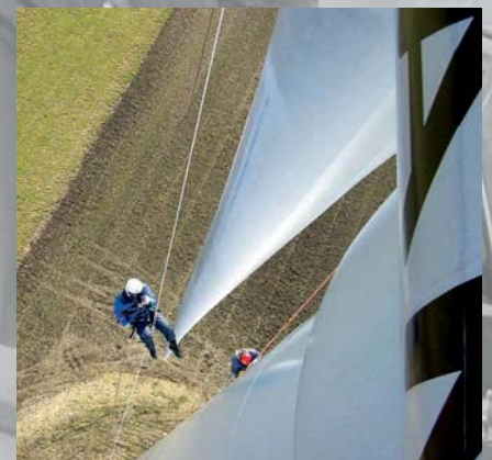
Zugangs- und Positionierungsverfahren am Rotorblatt
